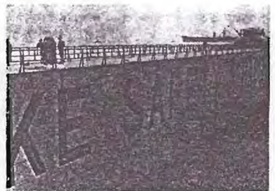
図 12 MSHI 修繕ドックゲート MSHI repair dock gate
