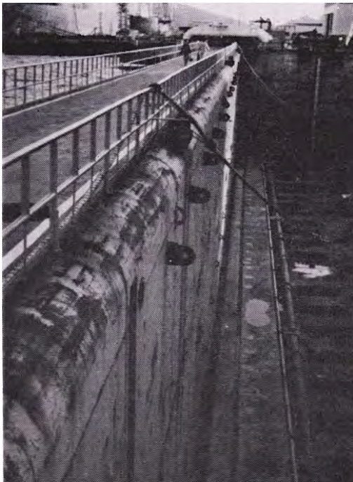
図 - 6 振り形式大規模フラップゲート (長崎県、1973年完成)
